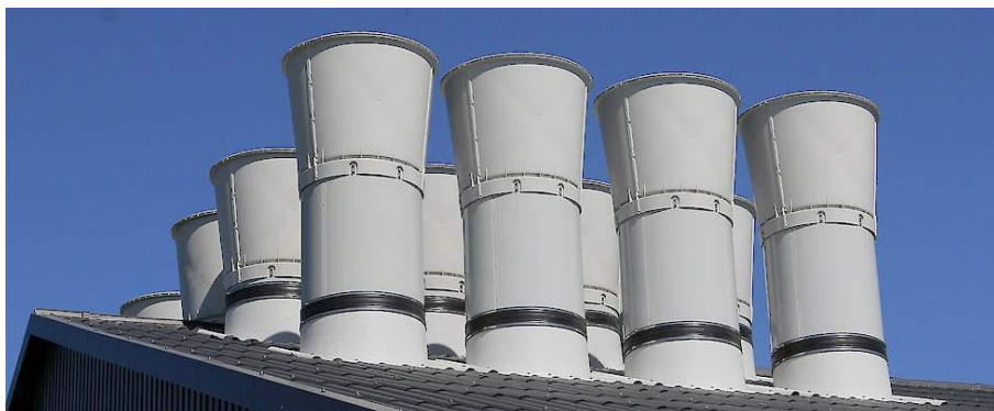
Figuur 6.5: Voorbeelden van stallen met geclusterde ventilatoren. Hier worden de oppervlakken van de emissiepunten niet gemiddeld maar samengenomen.
